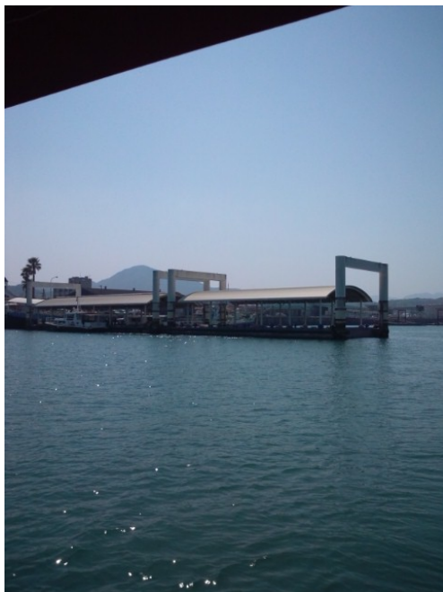
本渡港のフェリー桟橋
